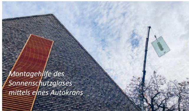
*Montagehilfe des Sonnenschutzglases mittels eines Autokrans*
