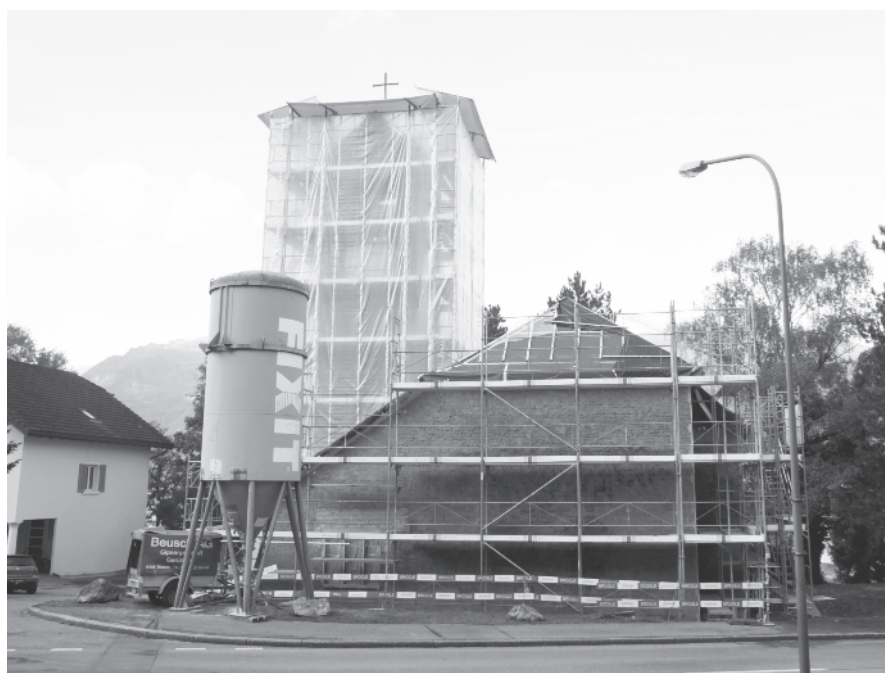
Die Kirche bedarf nicht nur geistlich immer wieder der Erneuerung – auch die äusseren Mauern müssen von Zeit zu Zeit saniert werden. Im Bild das eingerüstete St. Josefskirchlein in Vaduz-Ebenholz, erbaut 1930/31. Foto vom September 2017.
