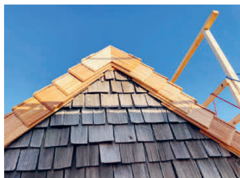
Oben: Giebel- und Ortabschluss mit neuen Lärchenschindeln. Unten: Der Bibliotheksteil mit der neuen Schindeldacheindeckung
