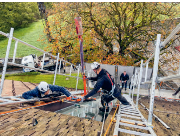
Einsetzen des Sonnenschutzglases beim ostseitigen Oberlicht
