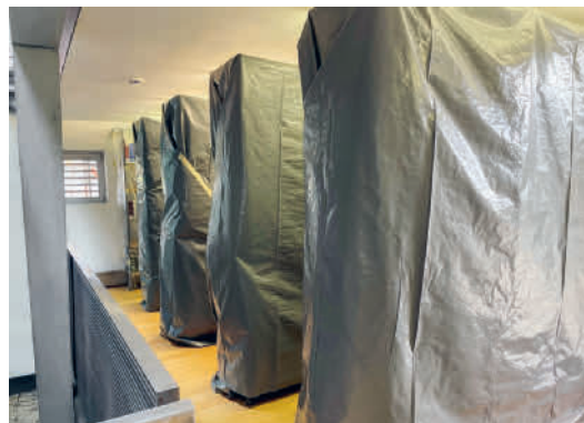
Vor Baustaub geschützte Bücherregale
