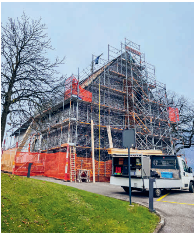
Der eingerüstete Gebäudeteil (vom Friedhof aus gesehen)
